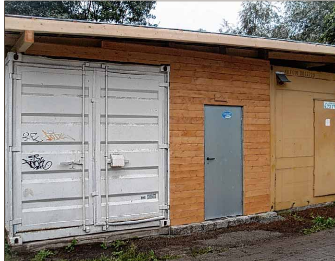
Hier haben sich die Mühlenfreunde ihre Lagerstätte für Baumaterialien eingerichtet. Die Container sollen noch verschönert werden.
